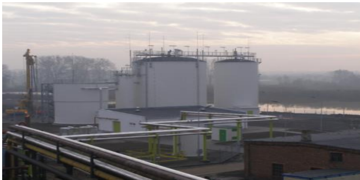
Budowa I etapu oczyszczalni ścieków.
